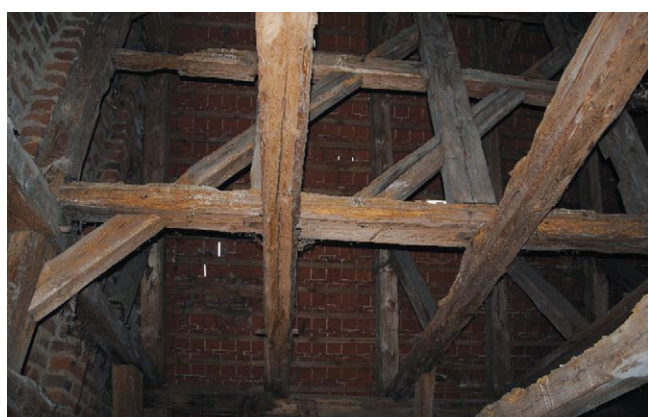
Rys. 7. Ugięte jętki i rygle
