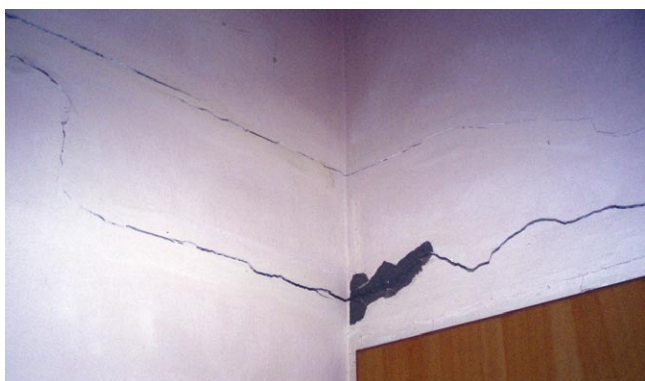
Rys. 3. Odsparzanie belek nadprożowych – budynek szkolny w województwie lubelskim
