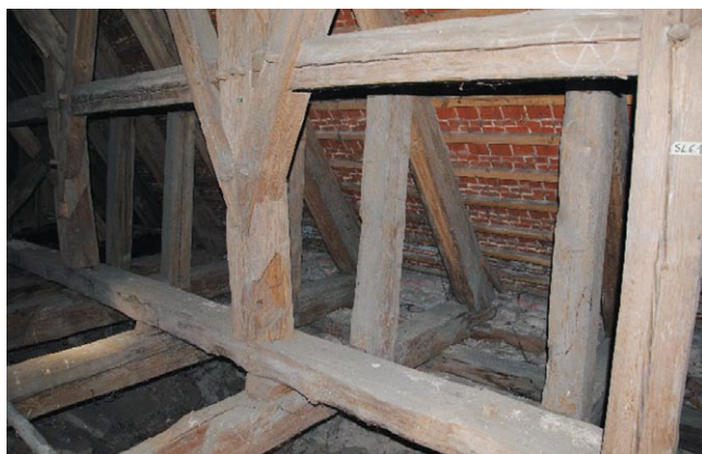
Rys. 12. Kliny pomiędzy płatwią dolną a belkami więzarymi
