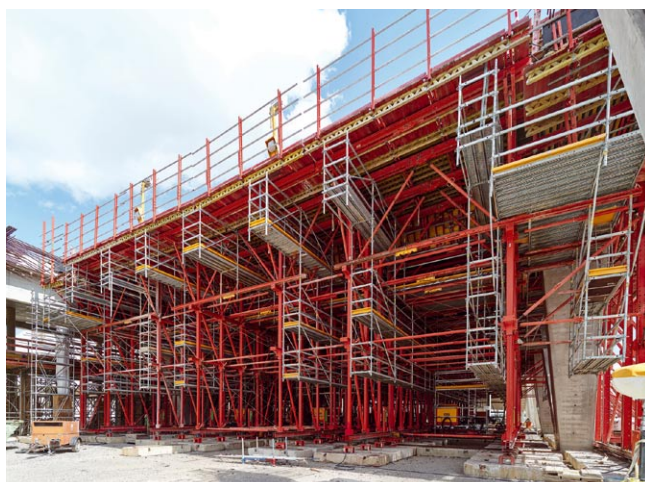
Platformy robocze zostały wykonane przy użyciu zestawu rusztowań PERI UP
