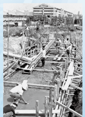
下水処理場の建設工事
