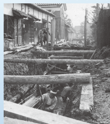
下水道管の布設工事 (桜通り)
