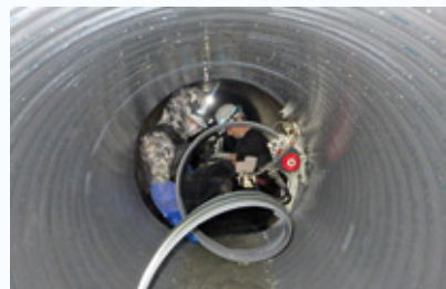
下水道管の耐震化工事の状況
