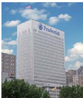
プルデンシャル・ファイナンシャル本社ビル (アメリカ合衆国ニュージャージー州 ニューアーク市)
